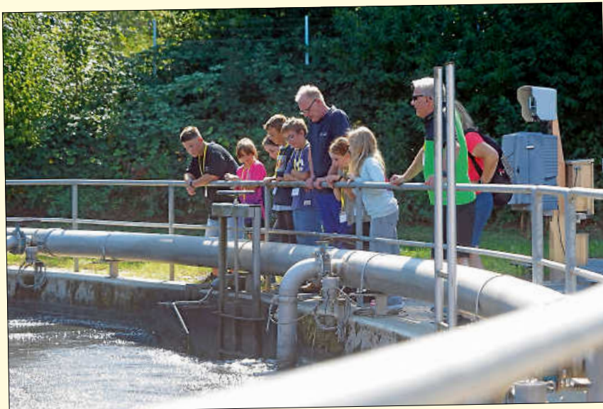
Wie gewaltig die Dimensionen des Königsbacher Klärwerks sind, zeigen allein schon die Belebungsbecken, die einen Durchmesser von 40 Metern haben und 5.000 Kubikmeter Wasser fassen. (rol)
