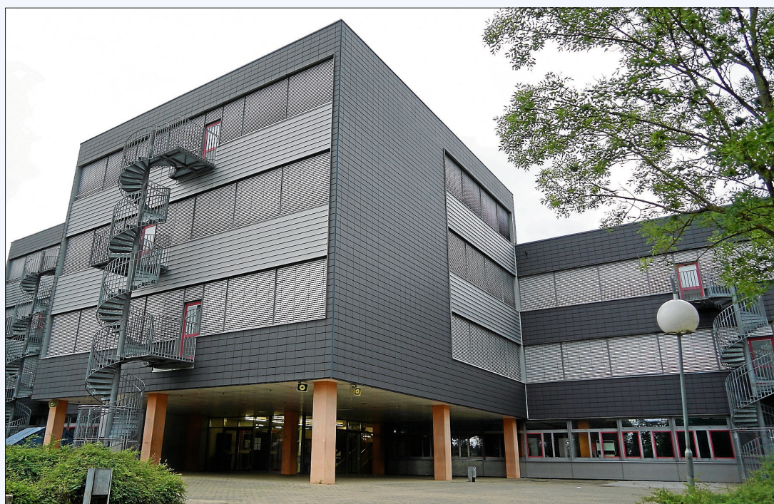
Wo sich jetzt im Untergeschoss noch ein überdachter Pausenhof für die Realschule befindet, sollen künftig neue Fachräume entstehen. Dazu wird der Bereich von Außenwänden umschlossen. Eine Bodenplatte und Anbindungen an die technische Infrastruktur sind schon vorhanden. Foto: (rol)
