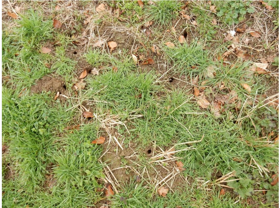
Foto 4: Mäuselöcher entlang des Damms.
