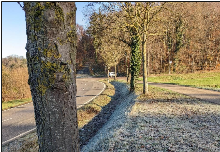
Foto 5: Entwässerungsgraben entlang der L611
