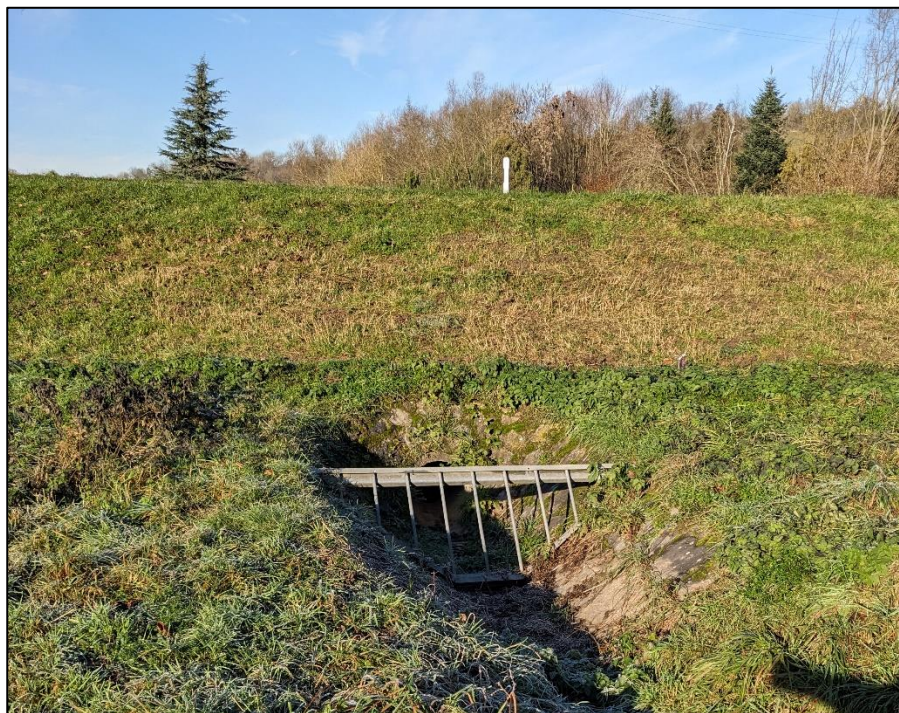
Foto 3: Bestehendes Auslassbauwerk des HRB Neulinger Grund
