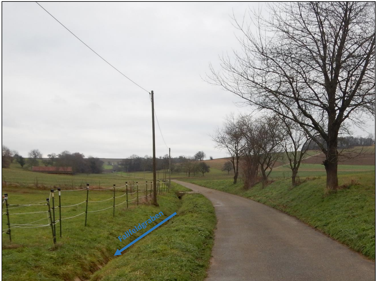
Abbildung 7.19: Austausch Wegedurchlass von DN400 auf DN600, HWS-Maßnahmen FF1 – FF3
