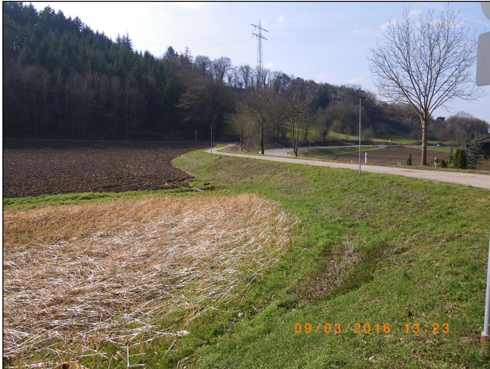
Abbildung 4.7: Wasserseitige Dammböschung HRB Neulinger Grund
