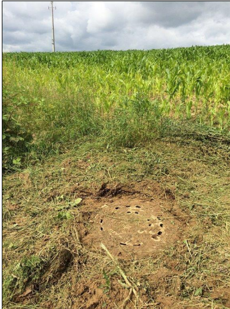
Abbildung 7.23: Freigeräumter Einlauf am Königsbacher Berg, massiver Materialeintrag aus angrenzender Ackerfläche, HW 25.06.2016 (Quelle: Gemeinde)
