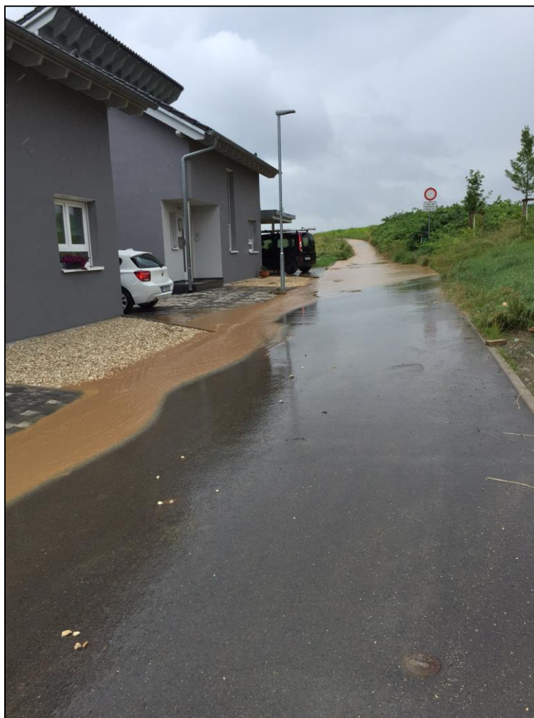
Abbildung 6.2: HW-Ereignis 25.06.2016, Königsbacher Berg, Abfluss über Straße (Quelle Anwohner)
