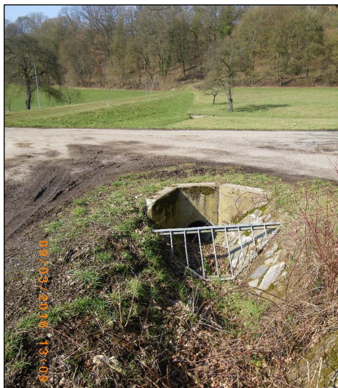
Abbildung 4.6: Seitlicher Zulauf zum Becken mit Rechen
