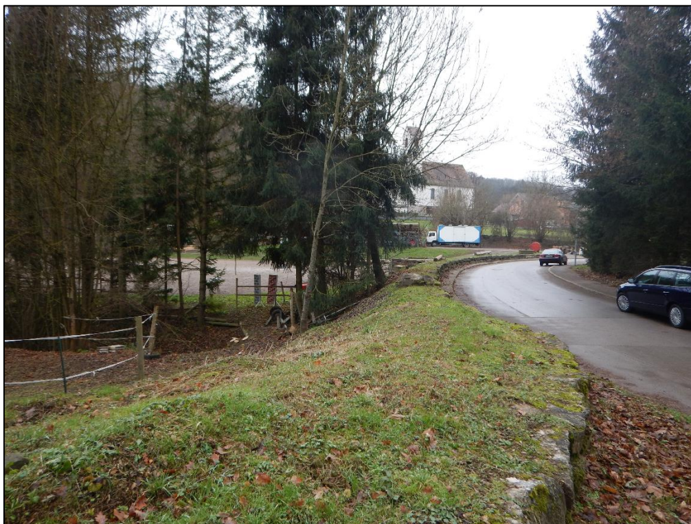
Abbildung 4.12: Bilfingerstraße auf der Dammkrone des HRB Gennenbachtal (Stauraum linksseitig)
