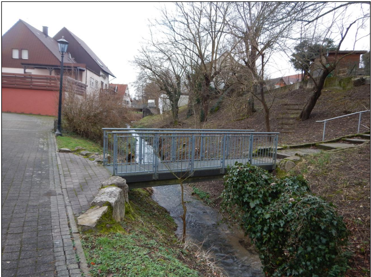
Abbildung 8.4: Neubau nicht vermessener Brücke am Bruchbach
