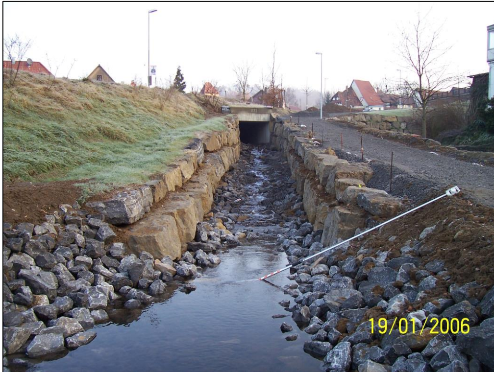
Abbildung 7.11: Verlängerung Mauer, HWS-Maßnahme BB6
