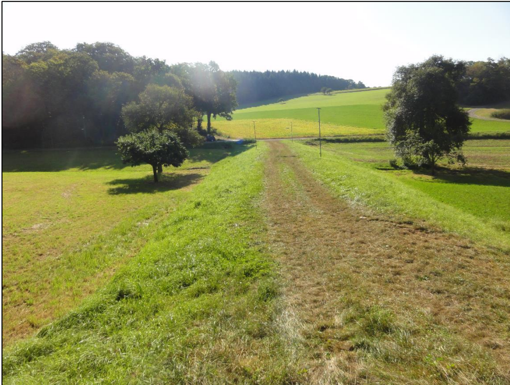
Abbildung 4.5: Dammbauwerk HRB Lindtal (Stauraum linksseitig)
