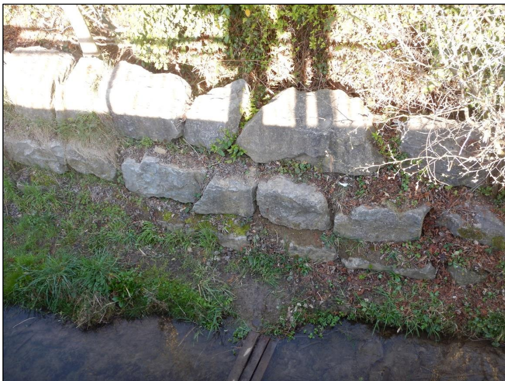
Abbildung 7.10: Ertüchtigung durchlässige HWS-Mauer, Maßnahme BB4
