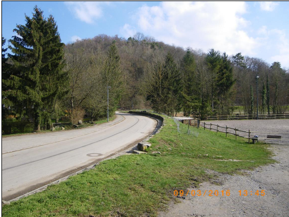
Abbildung 4.11: Bilfingerstraße auf der Dammkrone des HRB Gennenbachtal (Stauraum rechtsseitig)
