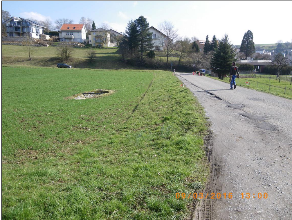
Abbildung 4.9: HRB Kuchental Absperrdamm mit Einlaufbauwerk Grundablass
