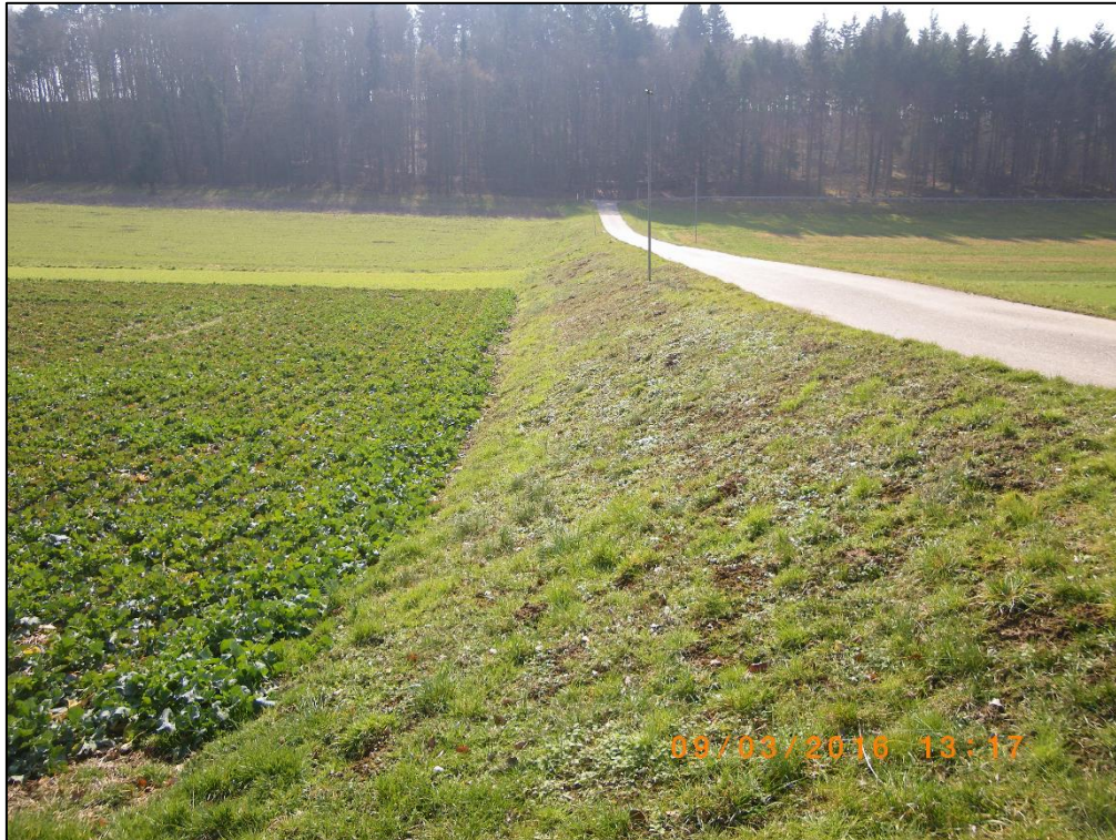
Abbildung 4.3: Dambauwerk HRB Pfitztal (Stauraum linksseitig)
