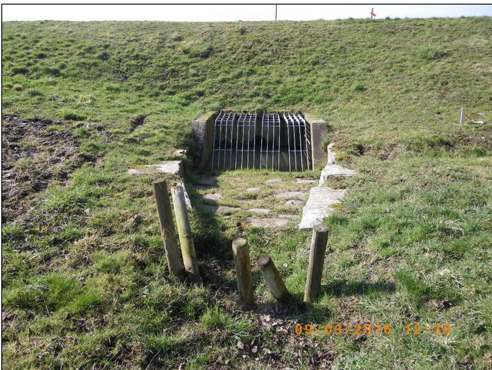
**Abbildung 4.6:** Auslassbauwerk mit räumlichem Rechen und vorgeschaltetem Grobrechen
