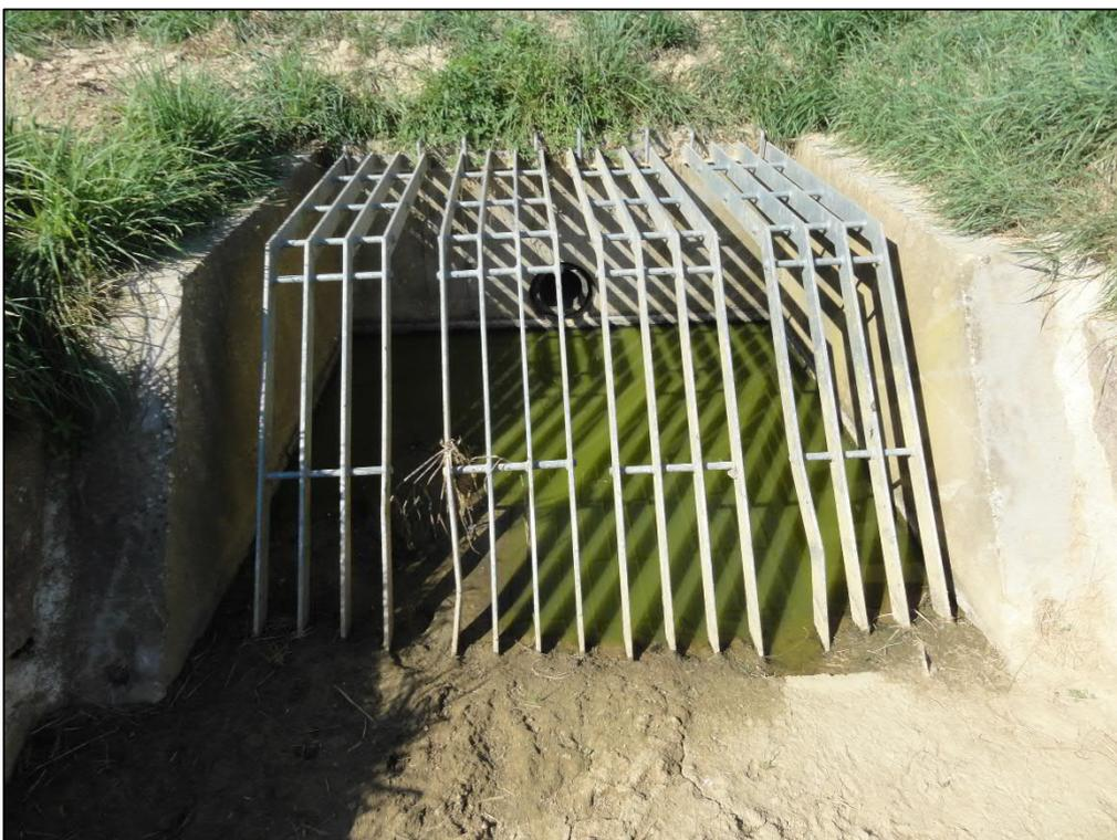
**Abbildung 4.8:** Auslassbauwerk mit räumlichem Rechen und Schlammablagerungen am 31.08.2016
