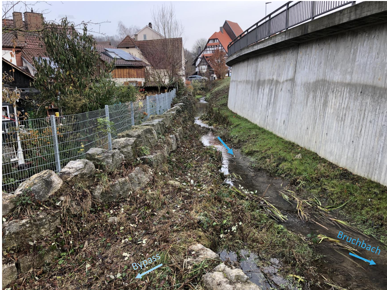
Königsbach-Stein: Hochwasserschutz am Bruchbach, Instandsetzung HRB Lindtal, HRB Pfitztal
